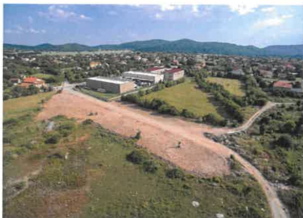
Slika 5. Izgled divljeg odlagališta nakon djelomične sanacije
